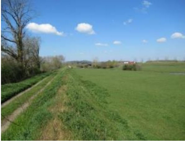
Chemin et talus (vue Est-Ouest)
