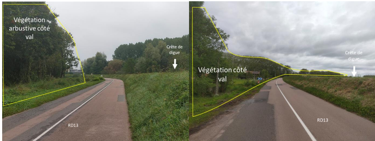
DIGUE DE SERMOISE (1ère section) PROFIL EN TRAVERS TYPE Pm 000 au Pm 450 (Massif filtrant)
