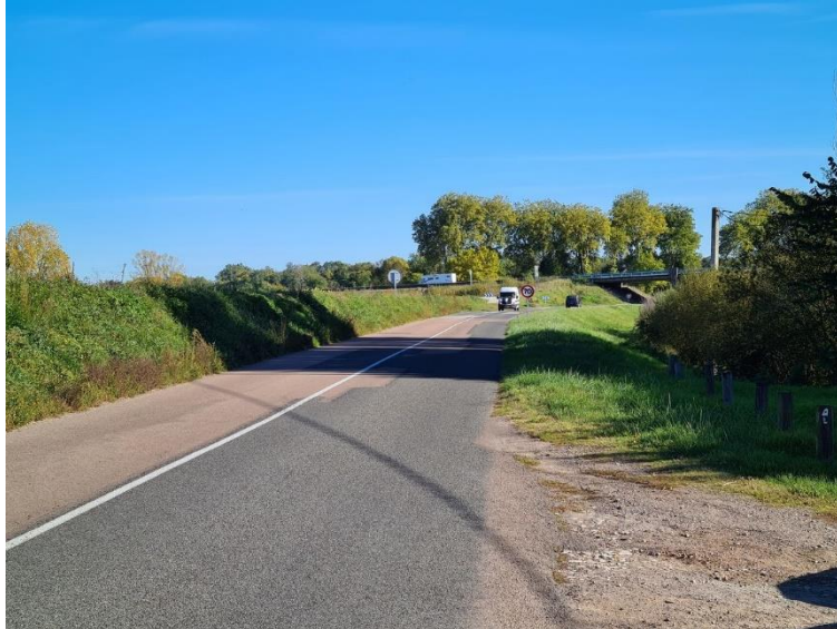
Figure 54 : Secteur 2 – depuis le remblai de l'A77 au PM1050
