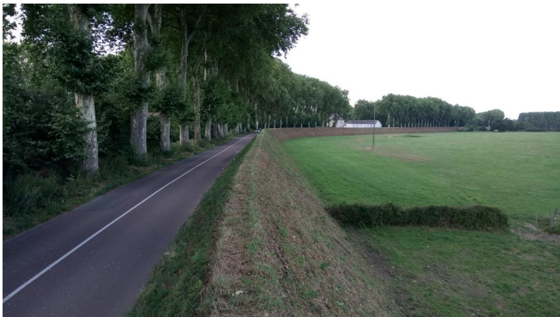
Photographie 1 : Profil type secteur 2 de la levée de Sermoise
