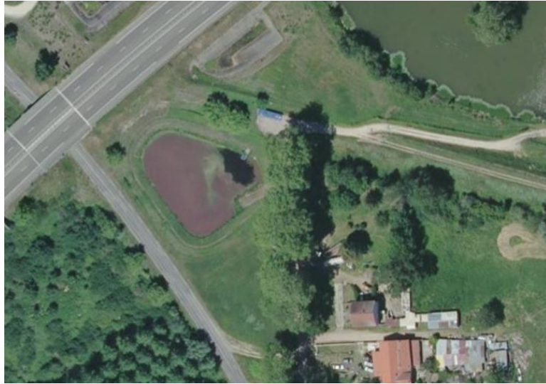
Figure 4 : Photographie aérienne du bassin de rétention des eaux pluviales à proximité de l'A77
